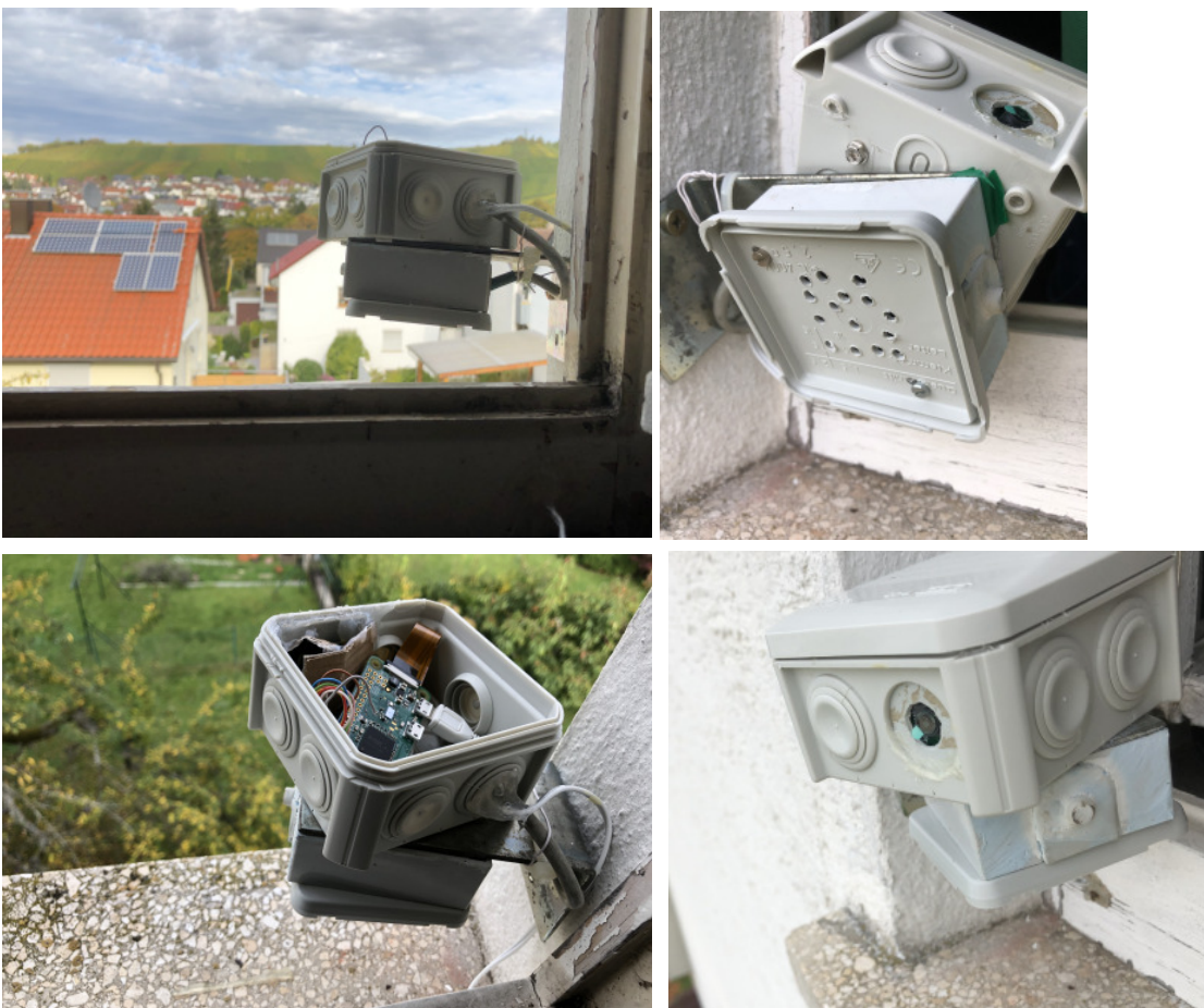
Abbildung 82: Entmontage der Wetterstation 10
